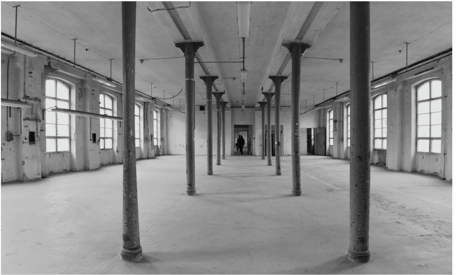
Interiér: Stávající stav
