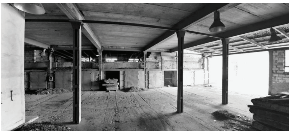
Vnitřní prostory sušárny
