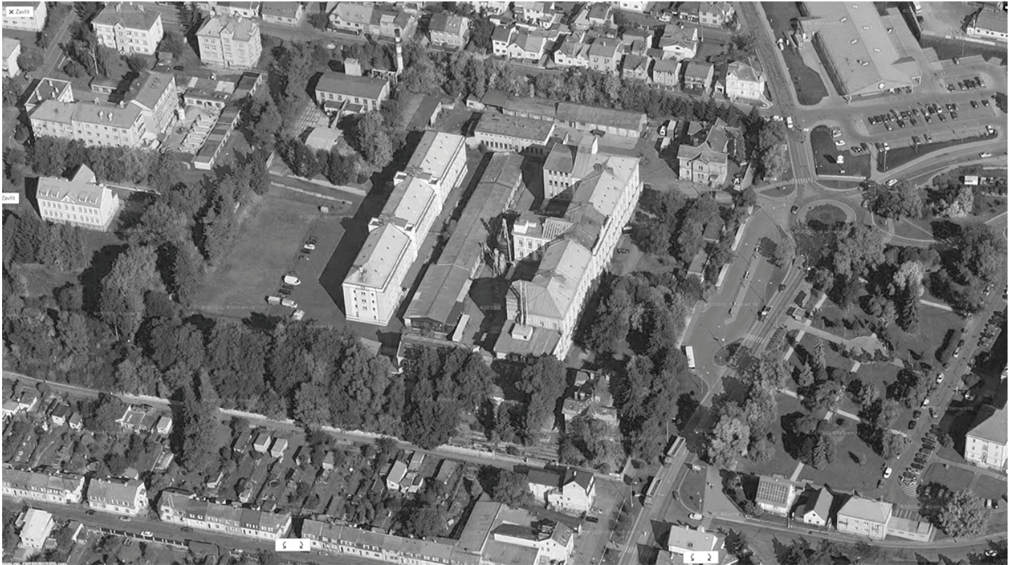
Stávající stav: nahléd
