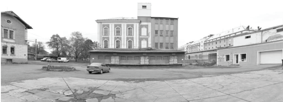
Pohled C: Severní fasáda budovy č.p. 715
