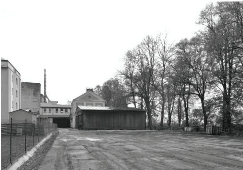
Pohled B: Skladovací hala se zpevněnou plochou, budova sušárny v pozadí
