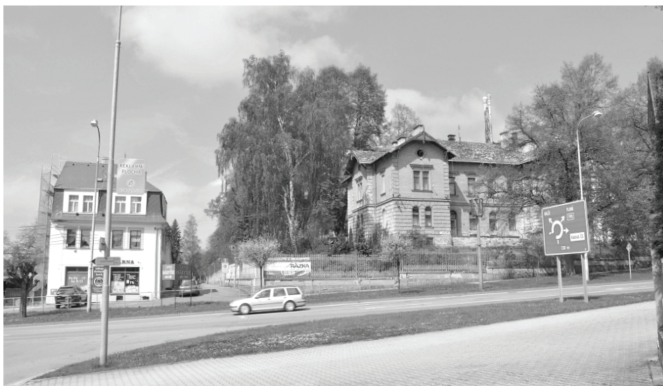
Pohled B: Pohled do ulice Pod Deltou, budova č.p. 787 vpravo
