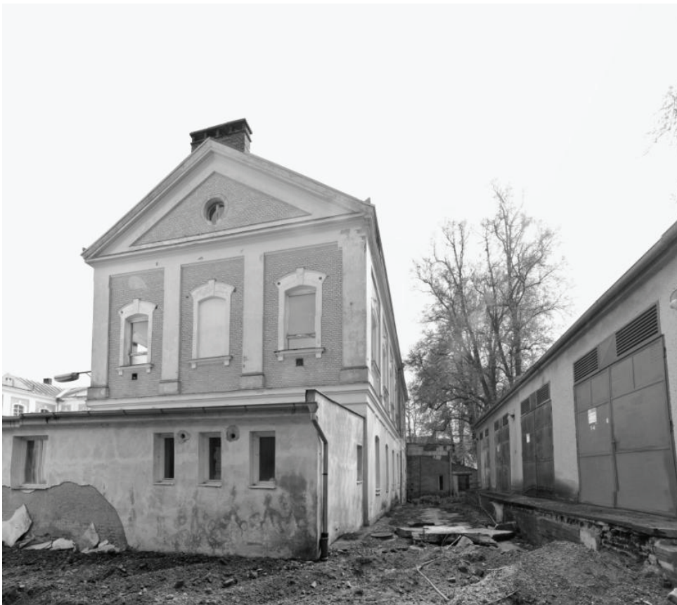
Pohled B: Budova trafostanice vpravo, budova jídelny vlevo
