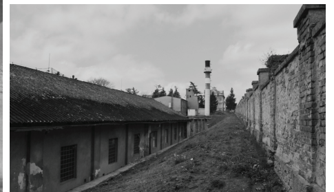
Pohled D: Zadní strana s oplocením, v pozadí kotelna
