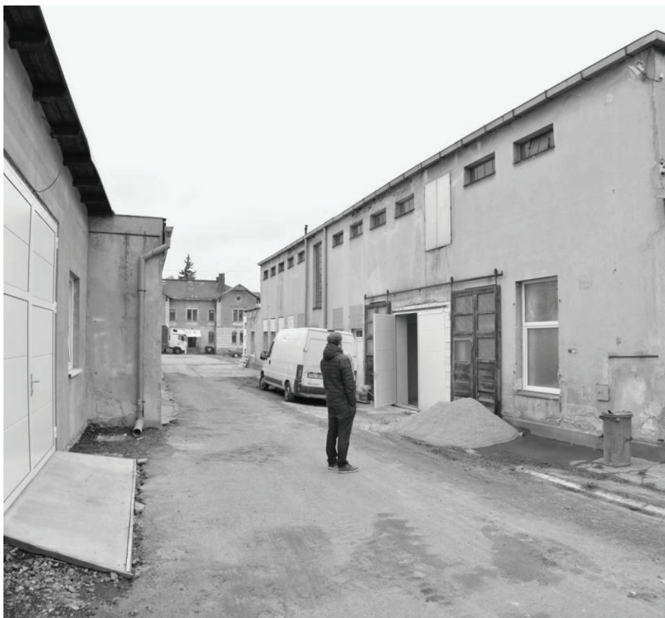
Pohled B: Boční strana budovy
