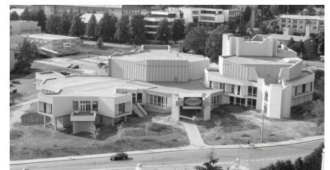
C - Nedostavěný kulturní dům 5 - moderní architektura
