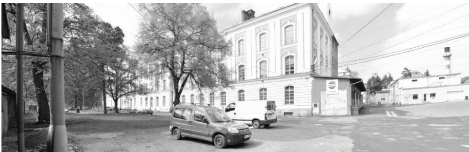
Pohled B: Pohled od příjezdu, budova č.p. 715 vlevo
