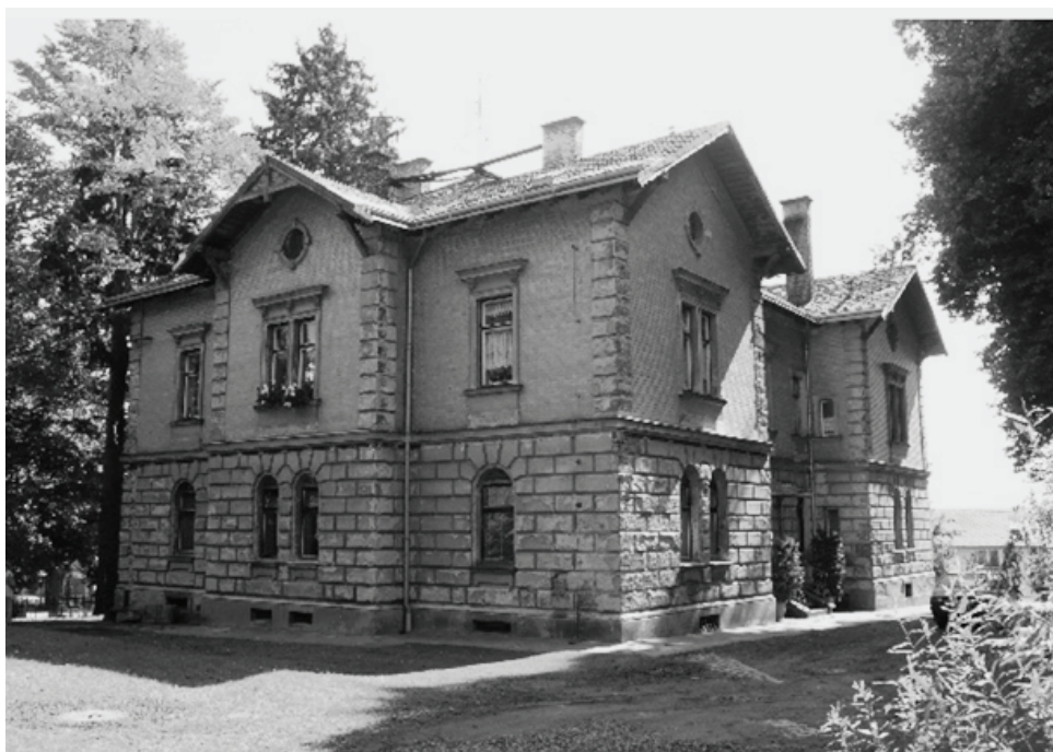
Pohled A: Budova č.p. 787
