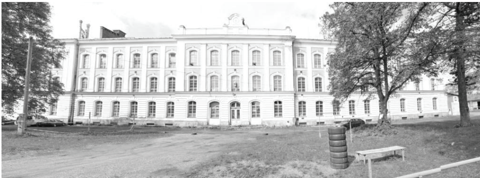
Pohled A: Budova č.p. 715
