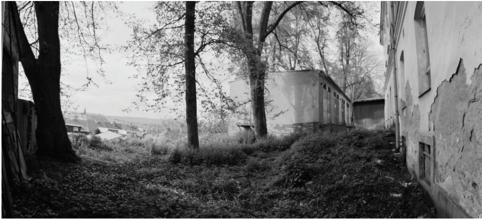
Pohled A: Budova trafostanice s budovou jídelny vpravo
