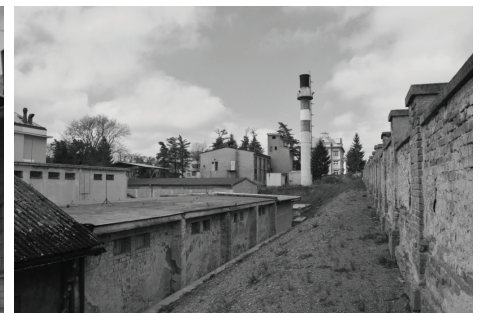
Pohled C: Zadní strana s oplocením, v pozadí kotelna
