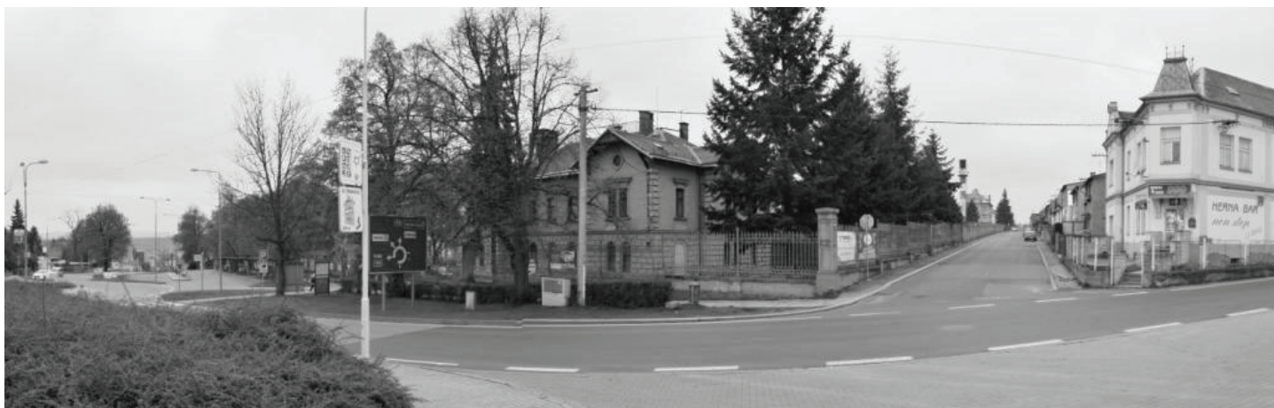
Pohled B: Pohled do ulice Tovární, budova č.p. 788 vlevo
