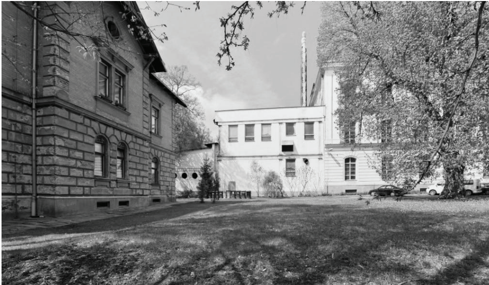
Pohled A: Budova sušárny v pozadí, vlevo budova č.p. 787
