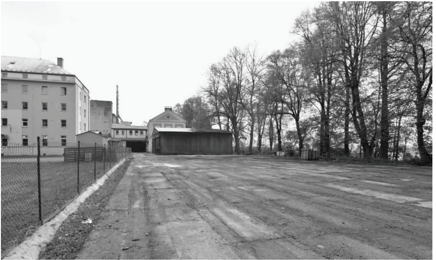
Pohled G: Stávající stav
