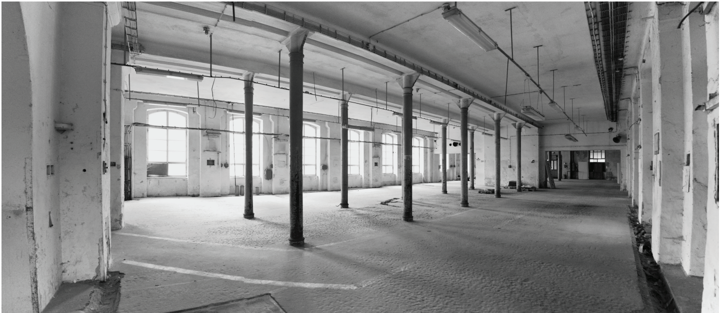
Interiér: Stávající stav
