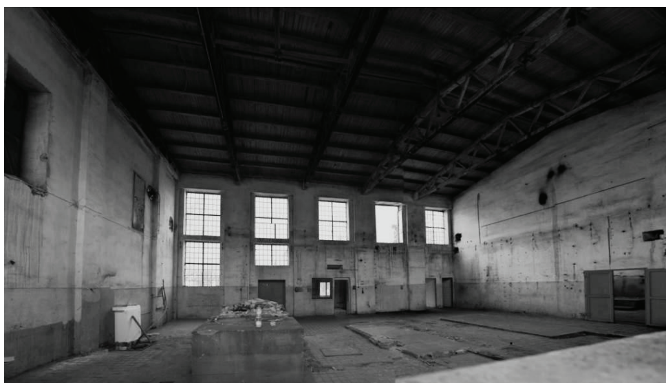
Interiér bývalé kotelny
