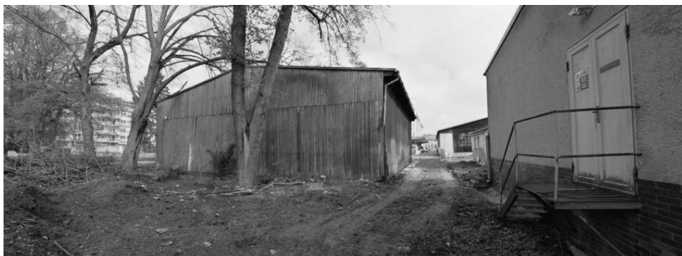
Pohled A: Skladovací hala vlevo s trafostanicí vpravo
