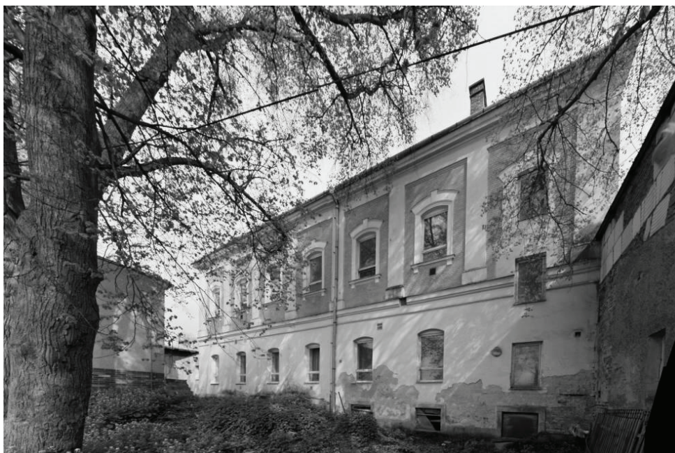
Pohled B: Budova č.p. 789
