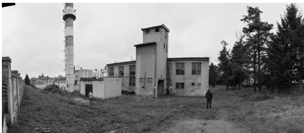
Pohled A: Pohled od vjezdu ke kotelně
